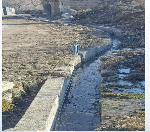
Ortabucak Köyü Sulama Kanalı
