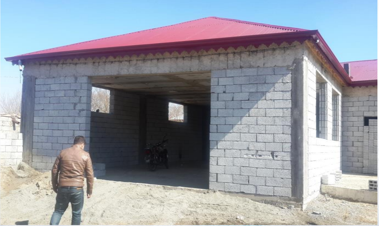
Aşevi inşaatı yapımı
