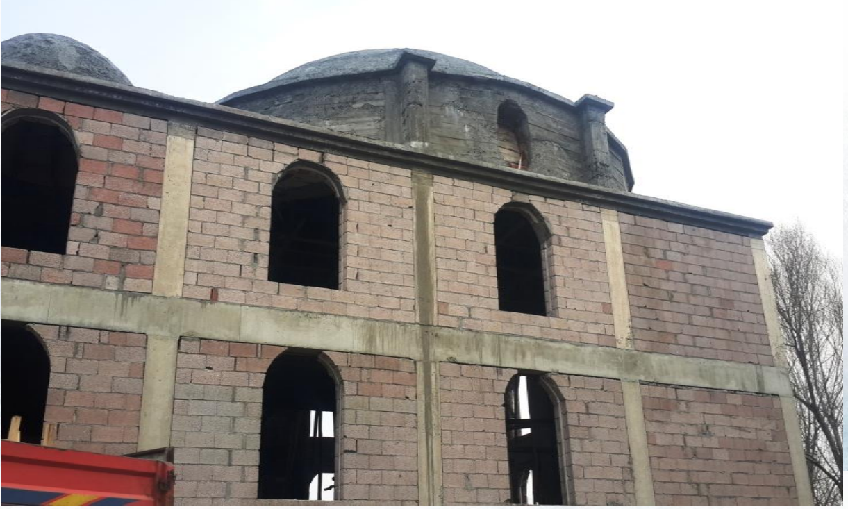
Cami inşaatı yapımı
