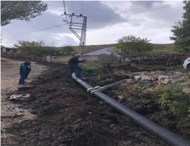
Kelekli Köyü Sulama Kanalı
