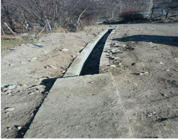
Kayakışlak Köyü Sulama Kanalı
