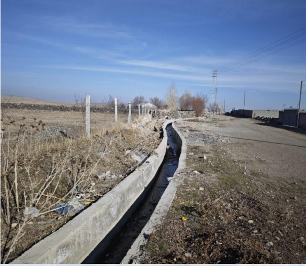
Mollakamer Köyü Sulama Kanalı
