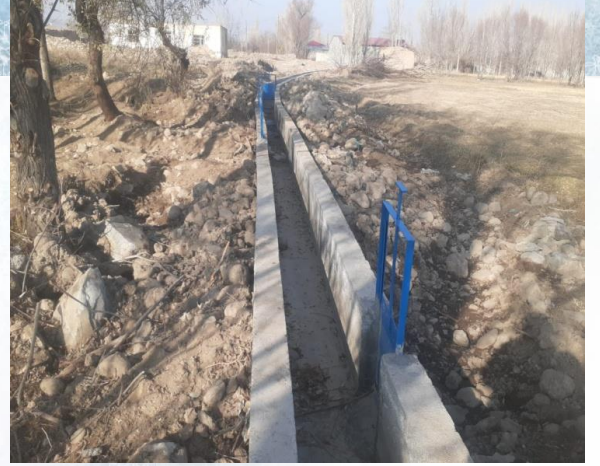
Yukarı Çivanlı Köyü Sulama Kanalı
