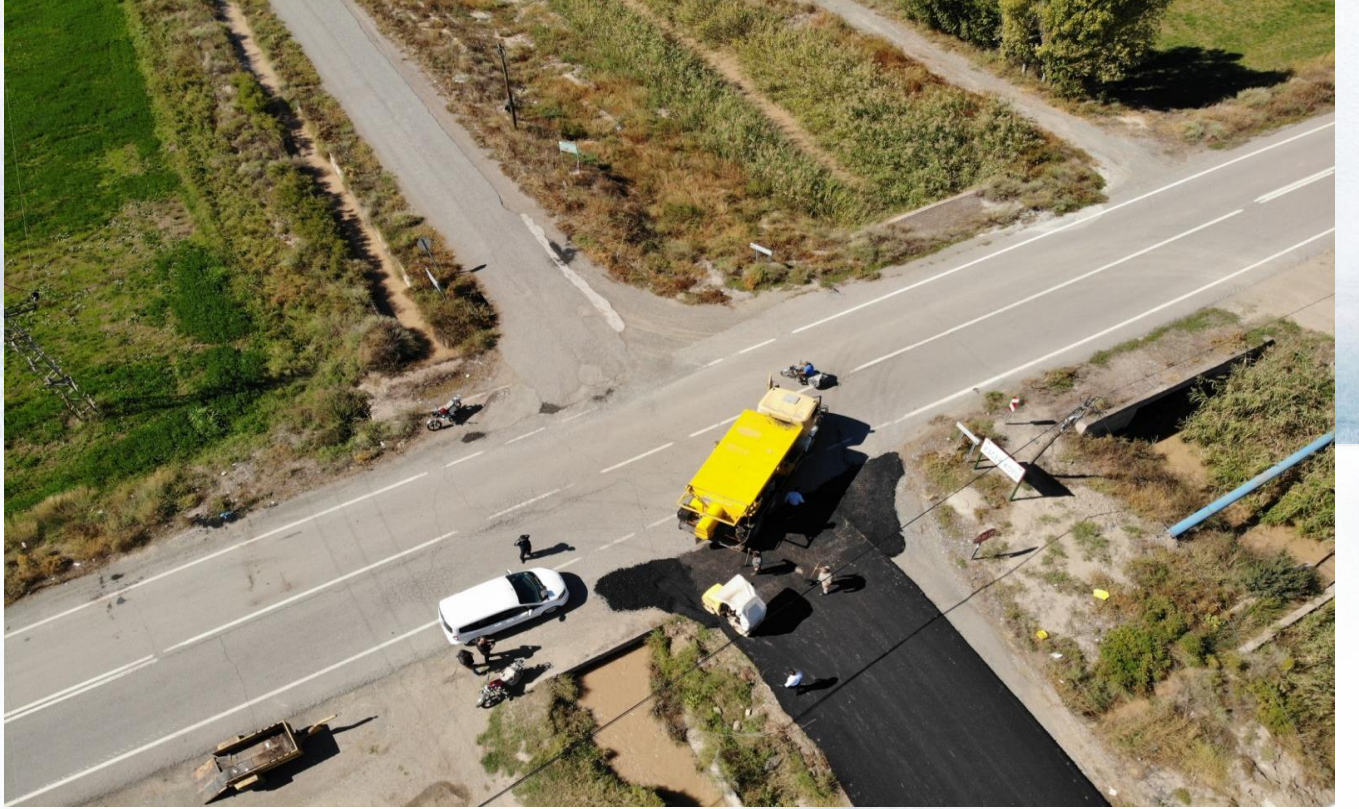
Kacerdoğanşanlı Köy Yolu Bsk Asfalt Kaplama (1,4 Km)
