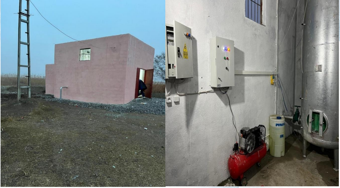
Iğdır İli Aralık İlçesi Yk.Topraklı Ve Aş.Topraklı Köyleri İçme Suyu Terfi Binası ile Şebeke Hattı Yapım İşi
