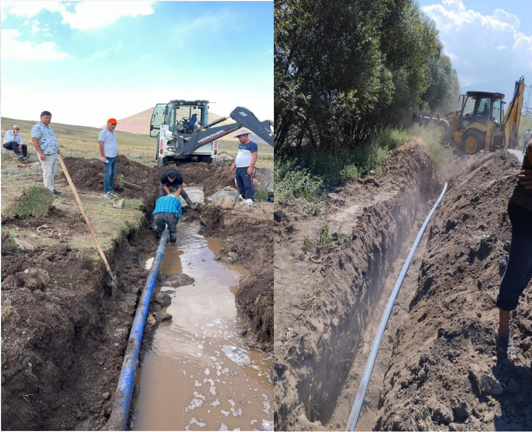
Köylerde İçme Suyu Bakım Onarımı Kapsamında Yapılan Çalışmalar
