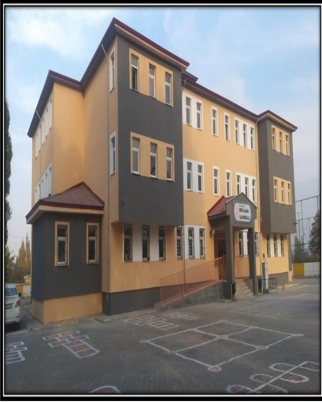
Merkez Mevlana İlkokulu Güçlendirme İşi
