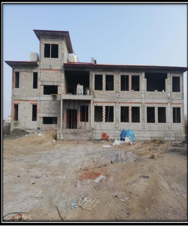
Karaağaç 8 Derslik Anaokulu Yapım İşi
