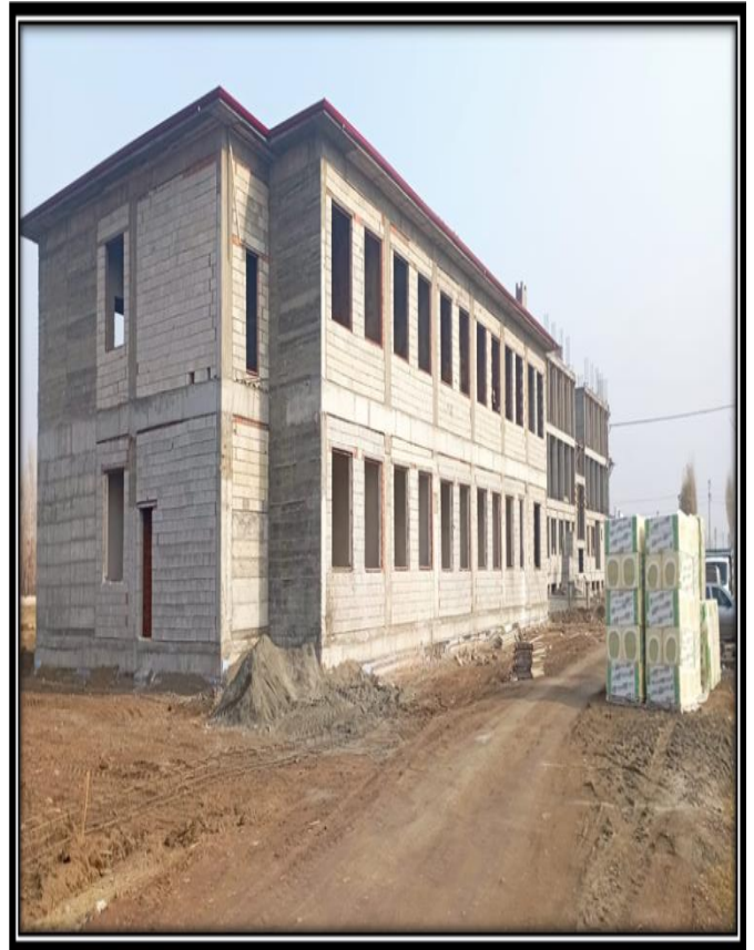
Söğütlü Mah. 8 Derslik Anaokulu Yapım İşi
