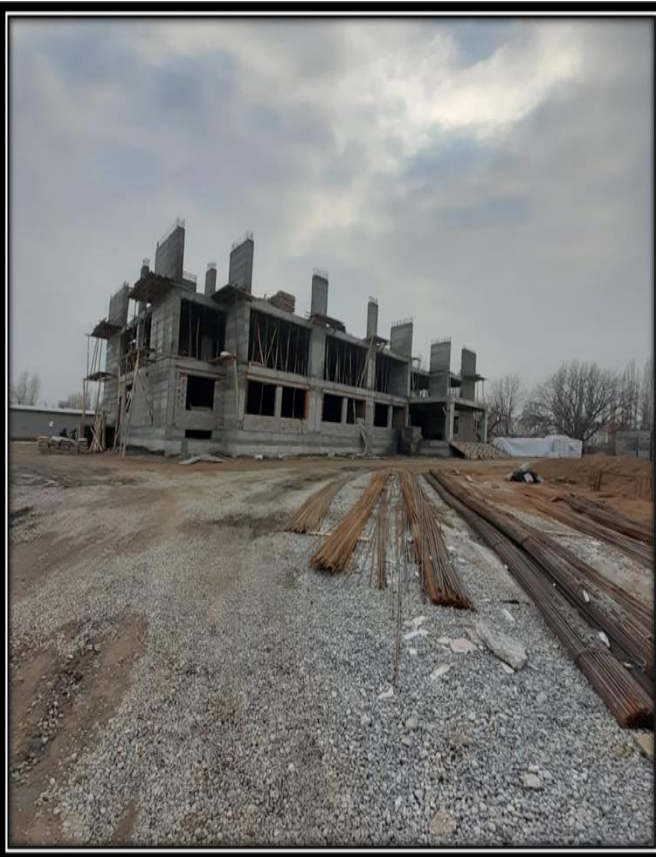
Halfeli 16 Derslik Okul Yapım İşi
