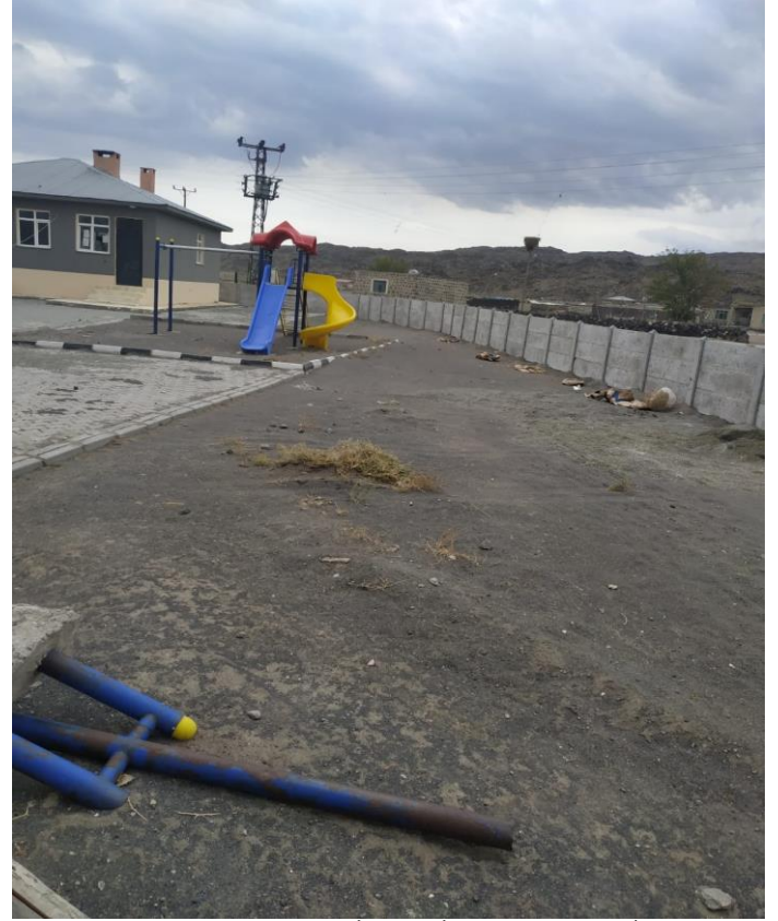
Adetli Köyü İlkokulu İhata Duvarı Yapım İşİ
