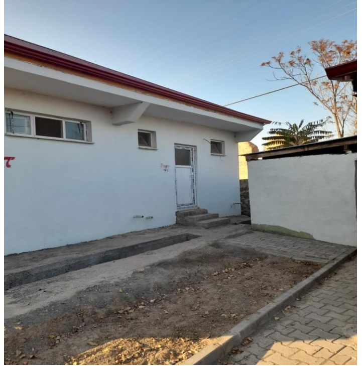
Kacerdoğanşalı cami onarımı ve çevre düzenlemesi
