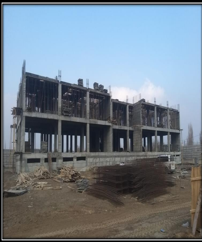
Konaklı Mahallesi 24 Derslik Okul Yapım İşi
