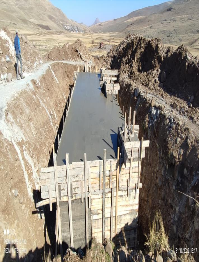
Tuzluca İlçesi Sarıbulak Köyü Kanalizasyon Fosseptik Çukuru Yapım İşi
