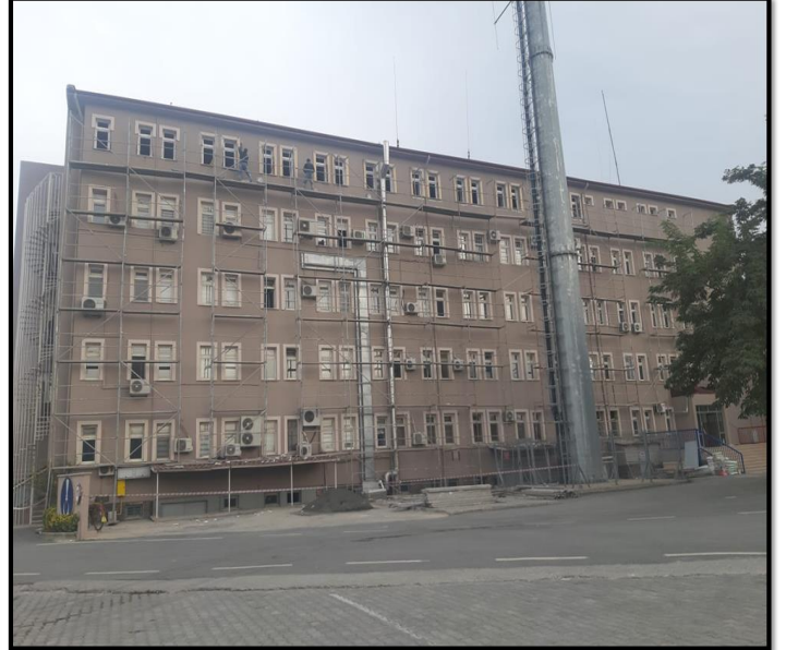
İl Jandarma Komt. Hizmet binası Bakım Onarım İşİ
