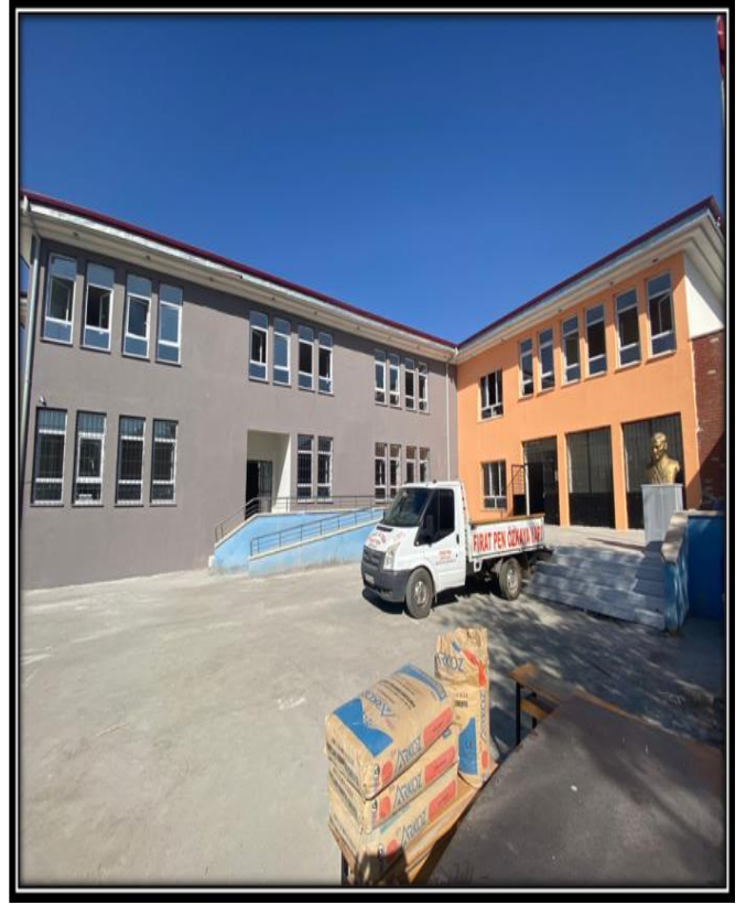
Karakoyunlu İlçesi Mürşitali İlk ve Ortaokulu Güçlendirme İşi
