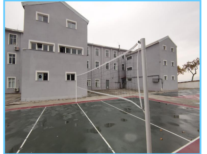
Suveren Jandarma Komando Tabur Komutanlığı Hizmet Binası Dış Cephe Mantolama Yapım İşİ
