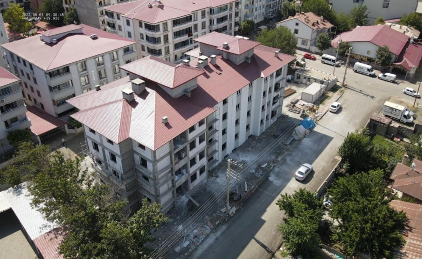
Emniyet Müdürlüğü 24 Dairelik Polis Lojmanları İnşaatı
