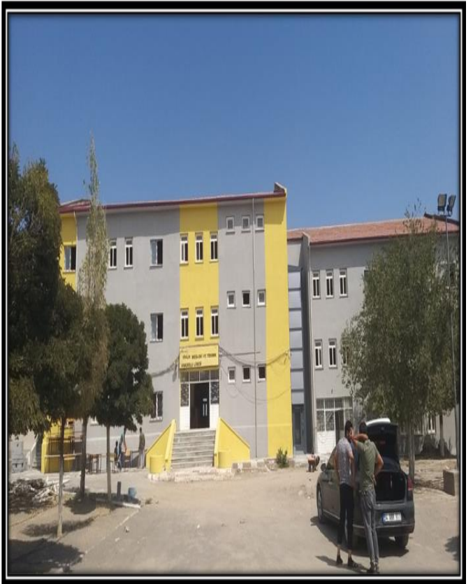
Aralık Mesleki ve Teknik Anadolu Lisesi Güçlendirme ve Onarım İşi
