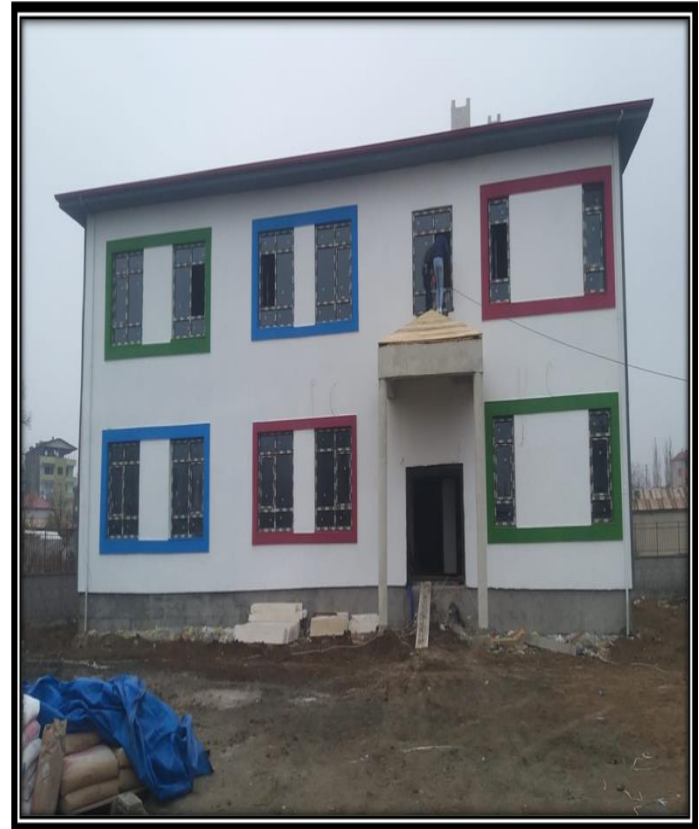
Emek Mahallesi 4 Derslik Anaokulu Yapım İşi
