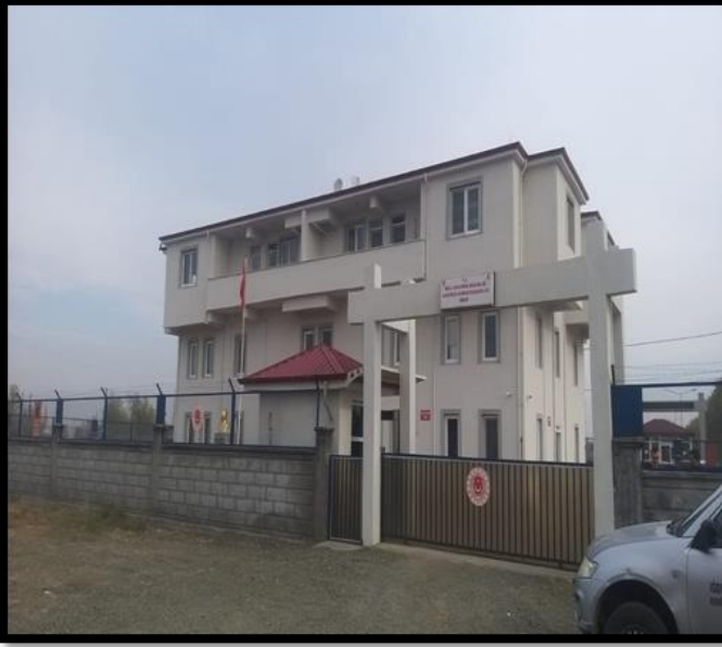
Askerlik Şubesi Yapım İşİ
