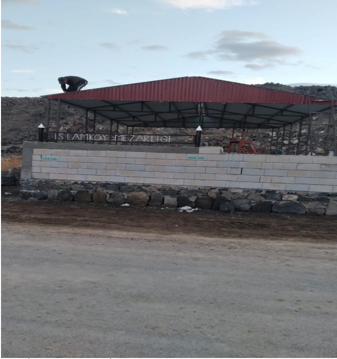
İslanköy Mezarlık İhata Duvarı Yapımı
