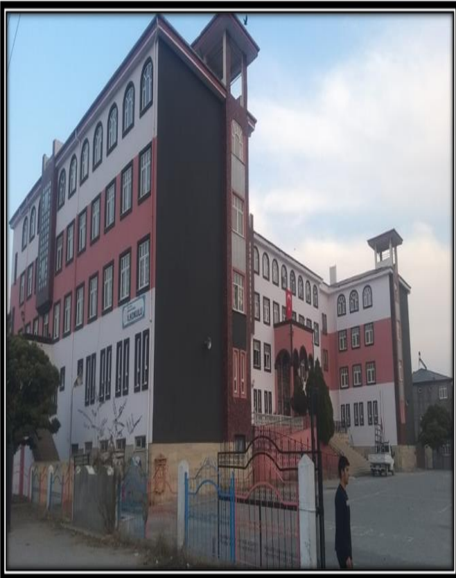
32 Derslikli Borsa İstanbul Temel Eğitim Okulu Güçlendirme ve Onarım İşi
