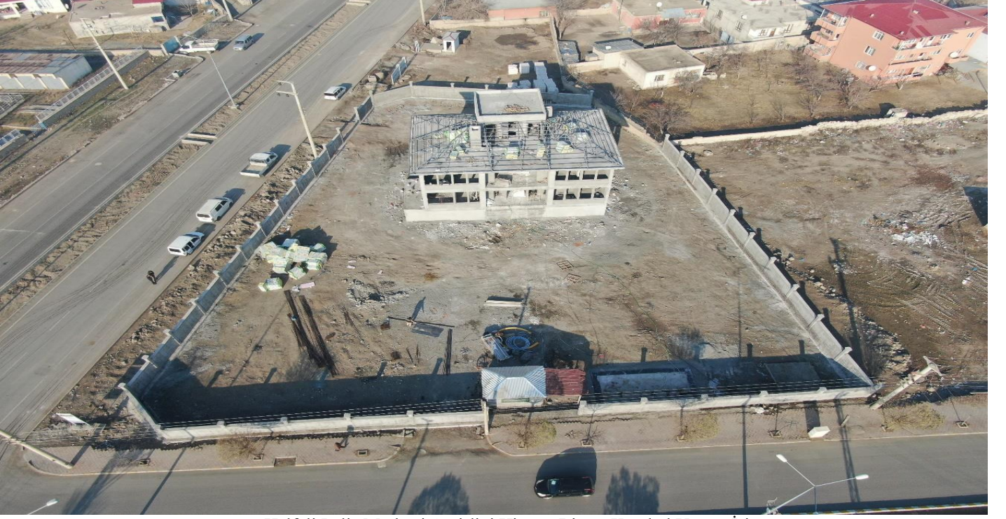
Halfeli Polis Merkezi Amirliđi Hizmet Binası Karakol Yapım İři
