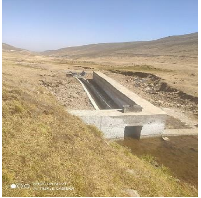
Arslanlı Köyü Sulama Tesisi
