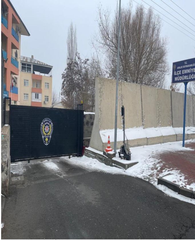
Aralık İlçe Emniyet Müdürlüğü Raylı Kapı Yapım İşİ
