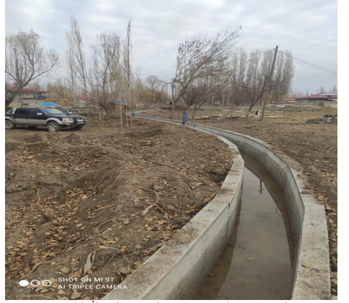
Aralık İlçesi Hasanhan Köyü Sulama Kanalı
