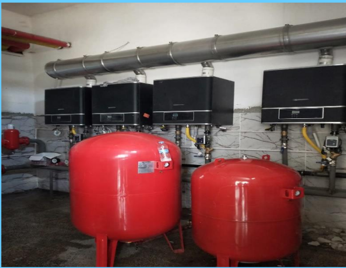
Suveren Jandarma Komando Tabur Komutanlığı Hizmet Binası Doğalgaz Dönüşüm İşİ
