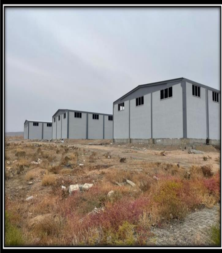
OSB 3 Adet Prefabrik Tekstil Kent İkmal İnşaatı
