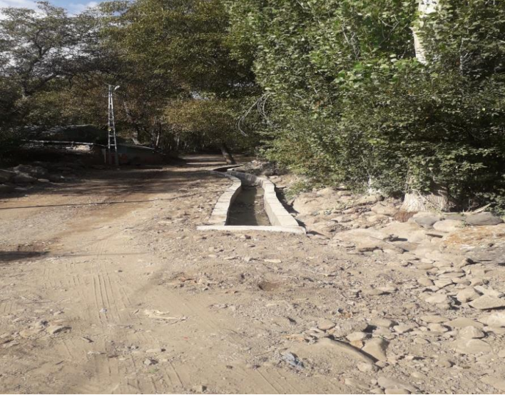
Tuzluca İlçesi Aliköse- Karakoyun-Üçkaya köyleri Sulama Kanalı
