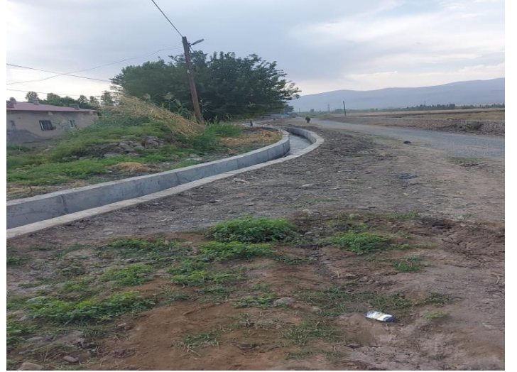
Merkez Yaycı Köyü Sulama Kanalı
