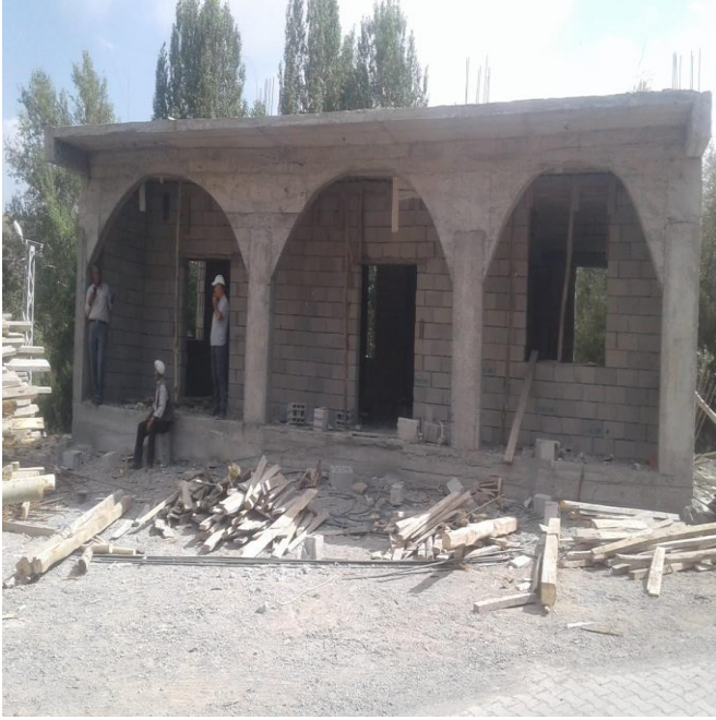
A.Sutaşı Köyü Cami Yapımı
