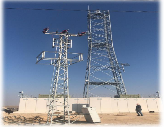
Aselsan Sınır Kulelerine Enerji Nakil Hattı yapım işi
