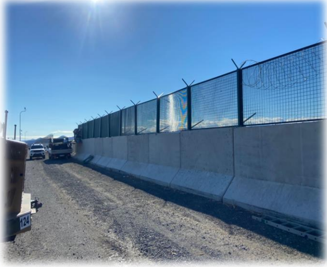
Iğdır İran Sınırına Yüksek Güvenlikli Panel Çit ve Iğdır Ermenistan Sınırına Kafes Tel Çit Yapımı
