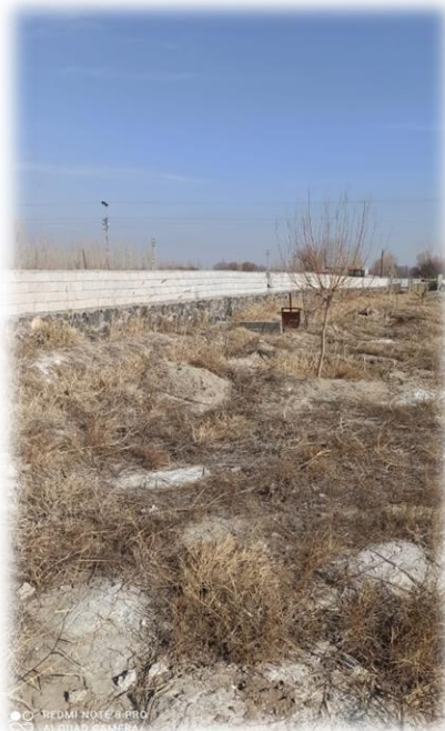
Hasanhan Köyü Mezarlık İhata Duvarı Yapımı
