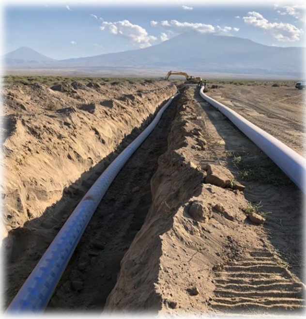
Aralık İlçesi Aş. Çamurlu, Yk. Topraklı, Aş. Topraklı, Saraçlı, Hacıağa, Tazeköy ve Ramazankent Köyleri İçme Suyu İsale Hattı ve 2 adet Branşman Yapım İşİ
