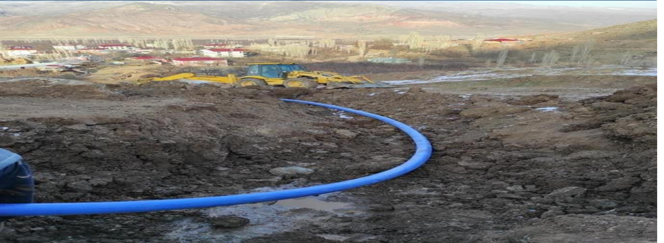
Tuzluca İlçesi İncesu Köyü İsale Hattı ve Yapım İşİ
