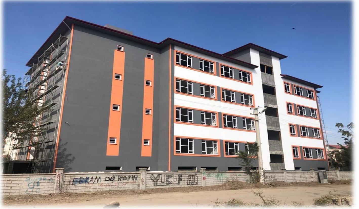
Merkez 16 Derslik İmam Hatip Ortaokulu Yapım İşi
