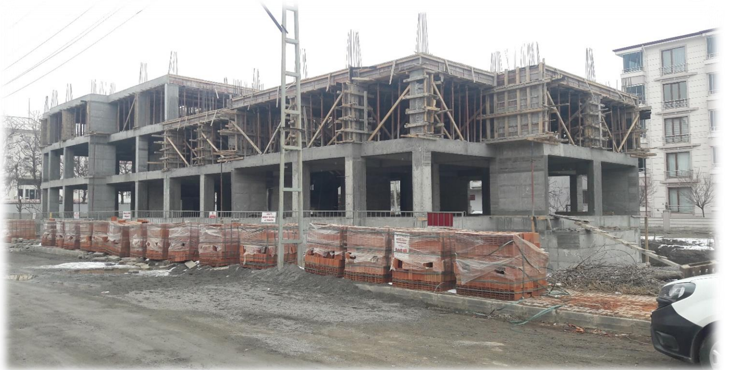
Emniyet Müdürlüğü 24 Dairelik Polis Lojmanları İnşaatı
