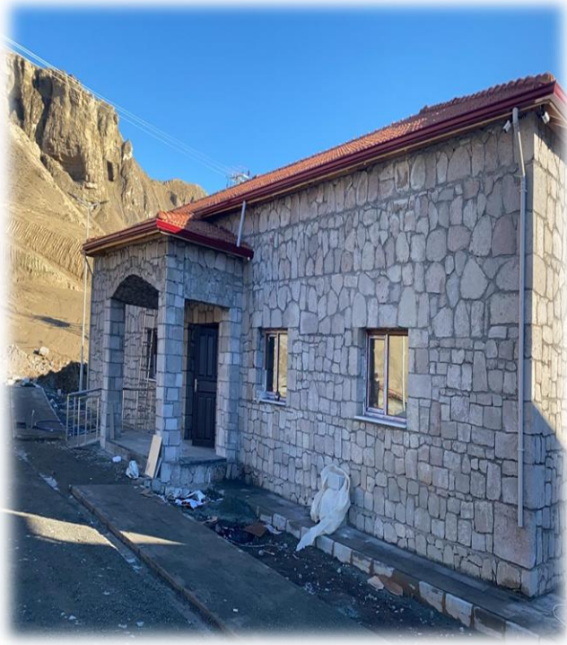
Tuz Terapi Merkezi Protokol Binası ve Çevre Düzenleme İşi
