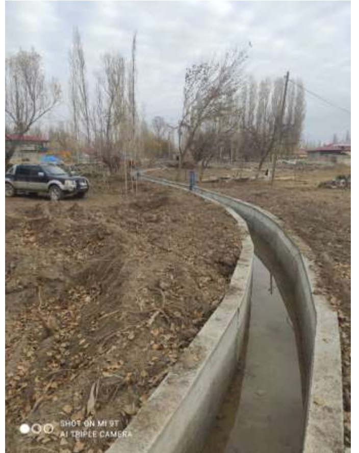
Aralık İlçesi Hasanhan Köyü Sulama Kanalı
