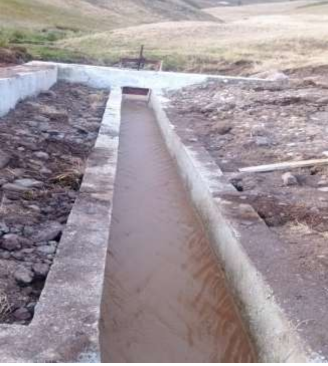
Yaylacık Köyü Sulama Tesisi
