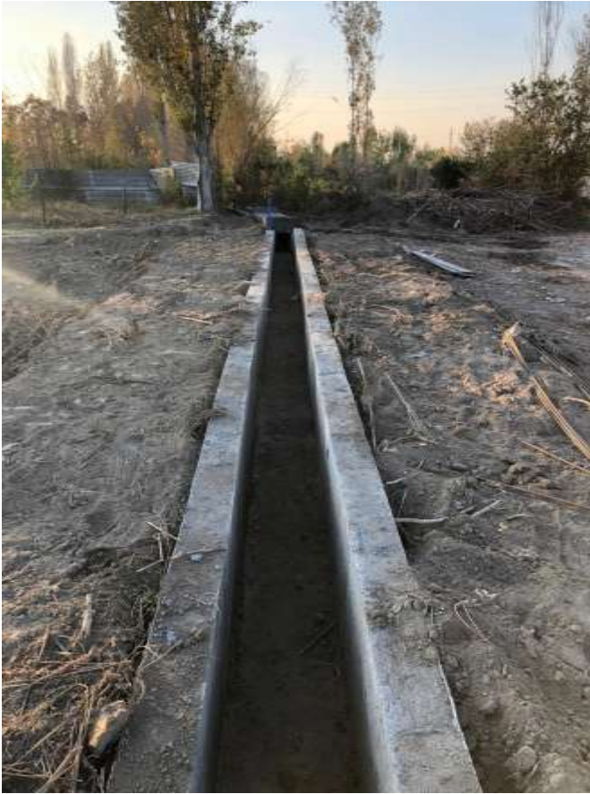
Hakmemet Köyü Sulama Kanalı
