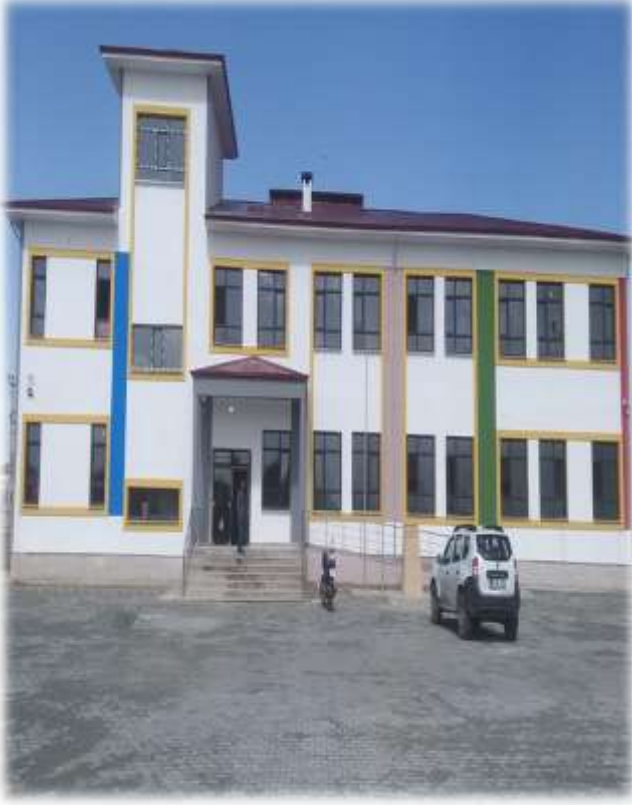
Karaağaç 8 Derslik Anaokulu Yapım İşi
