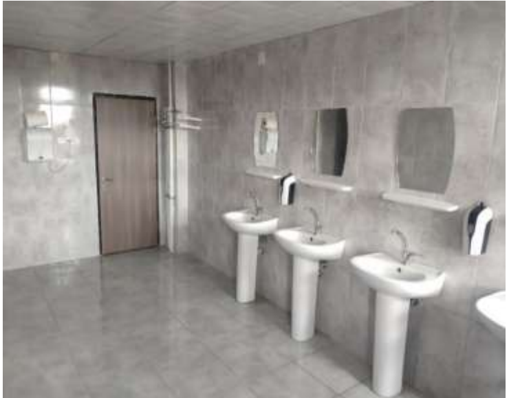
İğdır İl J.K.lığı Hizmet Binası Tuvalet Bakım Onarımı
