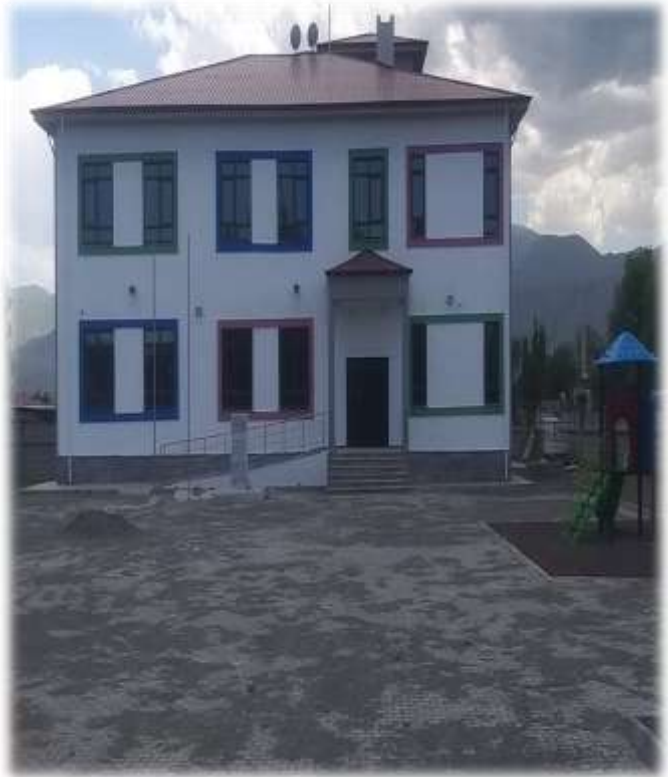
Emek Mahallesi 4 Derslik Anaokulu Yapım İşi
