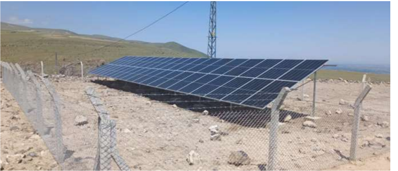
Suveren Köyüne İçme Suyu Sağlayan Tesisin Güneş Enerjisi Panelleriyle Çalıştırma Yapım İşi
