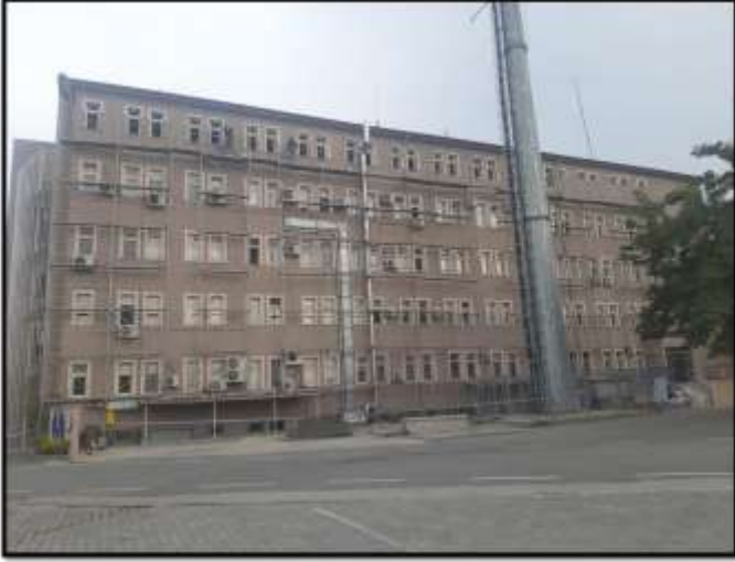
İl Jandarma Komt. Hizmet binası Bakım Onarım İşİ
