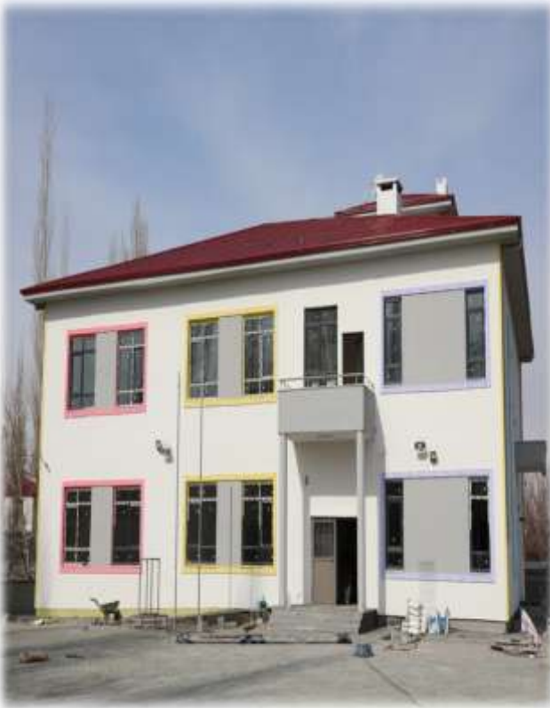
Halfeli 4 Derslik Anaokulu Yapım İşi
