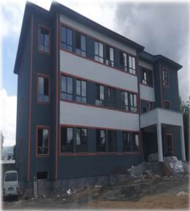
Halfeli 16 Derslik Okul Yapım İşİ
