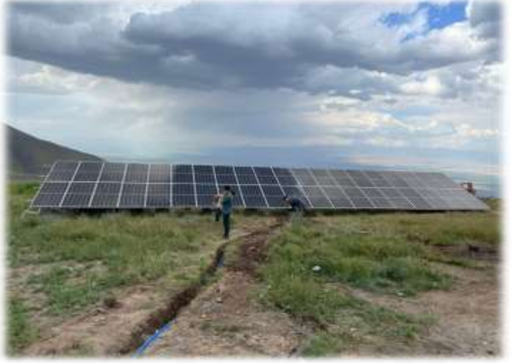
Gürgüre Jandarma GES Yapım İşİ
