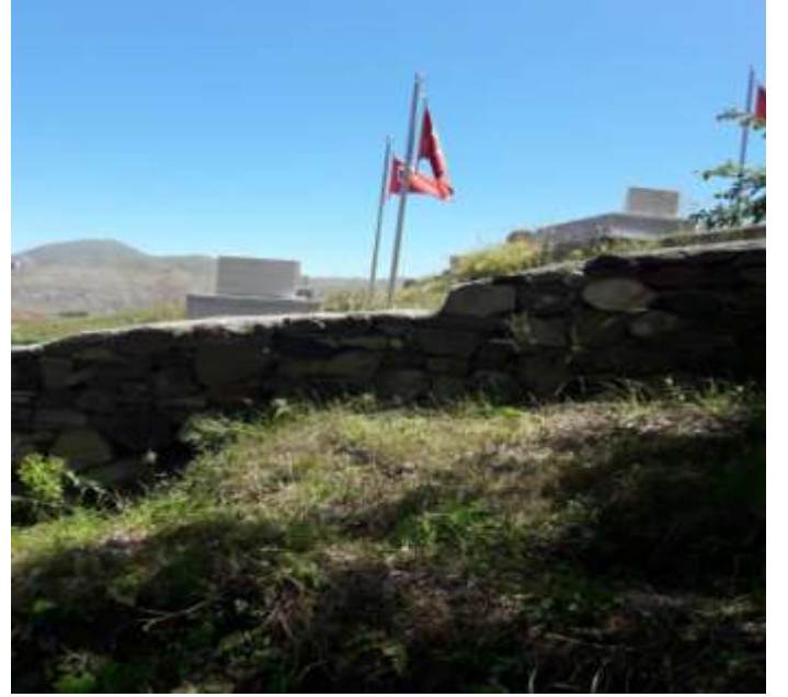
Mezarlık İhata Duvarı yapılması
