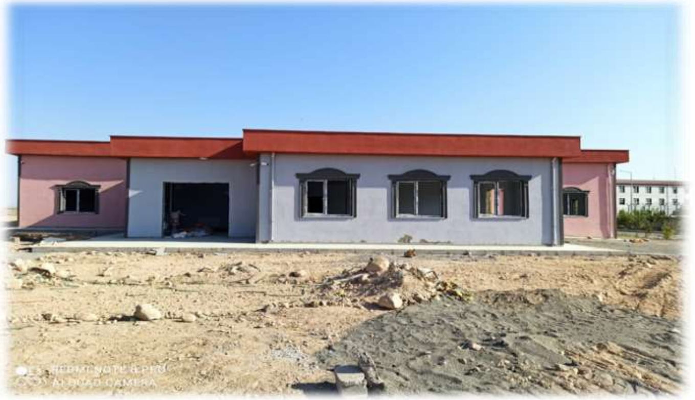
İğdır S Tipi Kapalı ve Açık Ceza İnfaz Kurumu Sosyal Tesis Yapım İŖi
