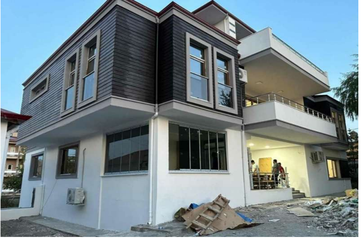
Tuzluca Kaymakamlık Konutu Yapım İŖi
