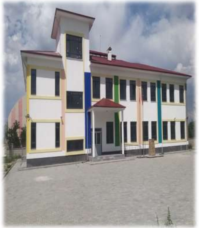
Bağlar Mah. 8 Derslik Anaokulu Yapım İşi
