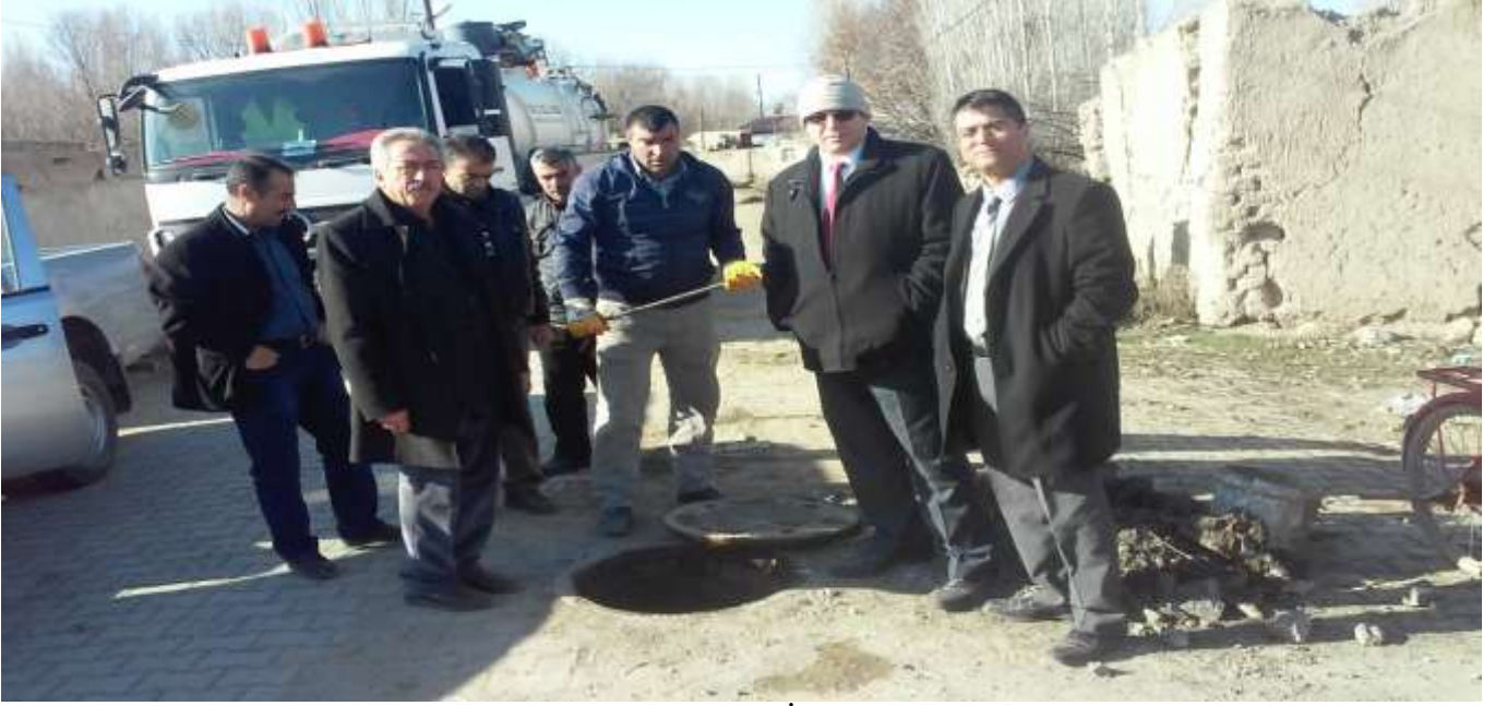
Kasımcan Köyü Kanalizasyon Şebekesi Bakım Onarım İşi
