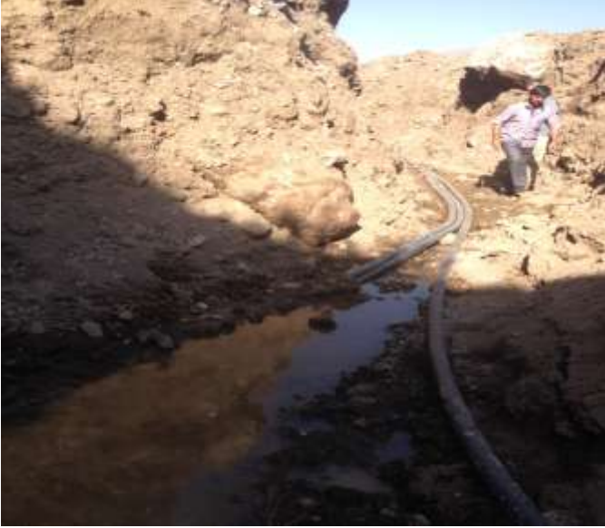
Asma Köyü Ek İçme Suyu Hattı yapım İşi
