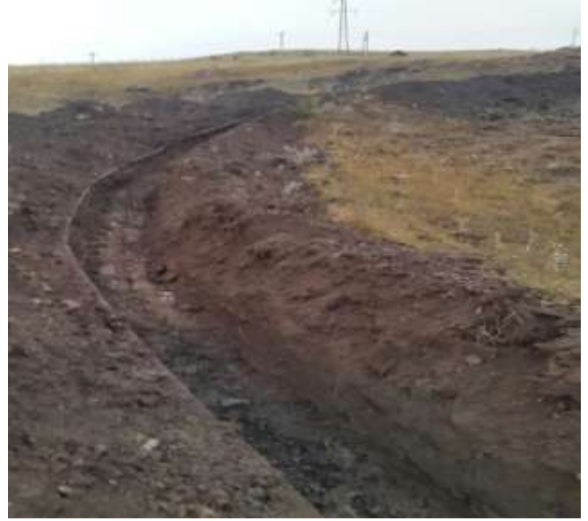
Bahçecik Köyü İçme Suyu İsale Hattı Yapım İşi
