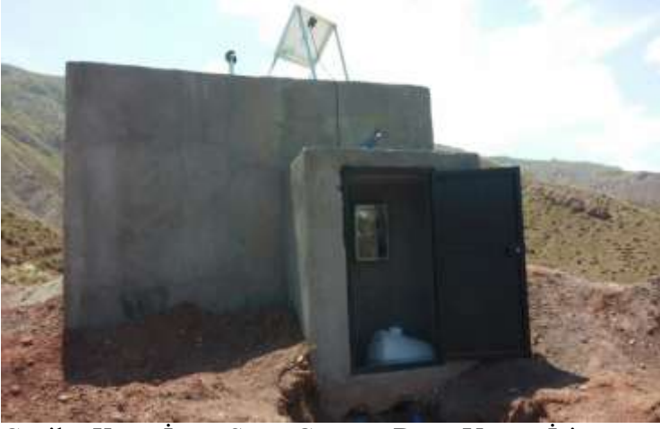
Gaziler Köyü İçme Suyu Gömme Depo Yapım İşİ
