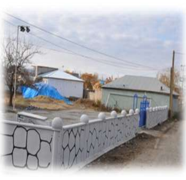
Akyumak Köyü Köy Konağı İhata Duvarı Yapımı
