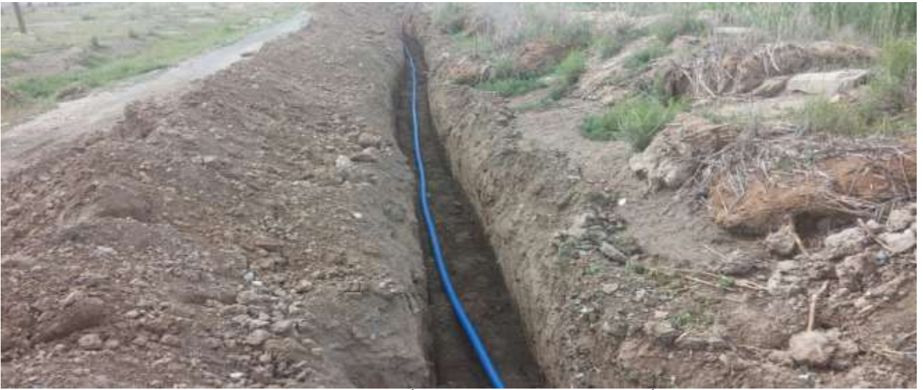
Taşburun Köyü İçme Suyu Bakım Onarım İşİ
