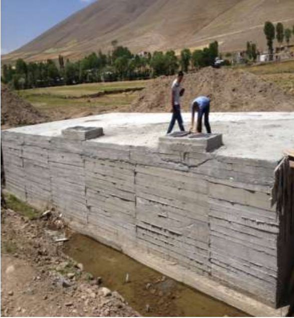
Abbasgöl Köyü Kanalizasyon şebekesi foseptik kuyusu inşaatı
