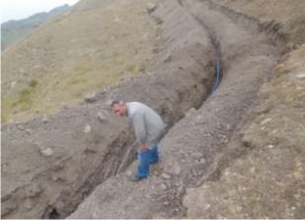
Elmagöl köyü, Bezirhane, Çiko ve Köprükoy Mezraları İçme Suyu kazı çalışmaları ve terfi binası inşaatı
