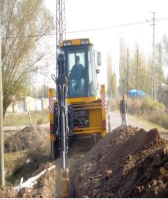
Yaycı köyü ek içme suyu hattı inşaatı
