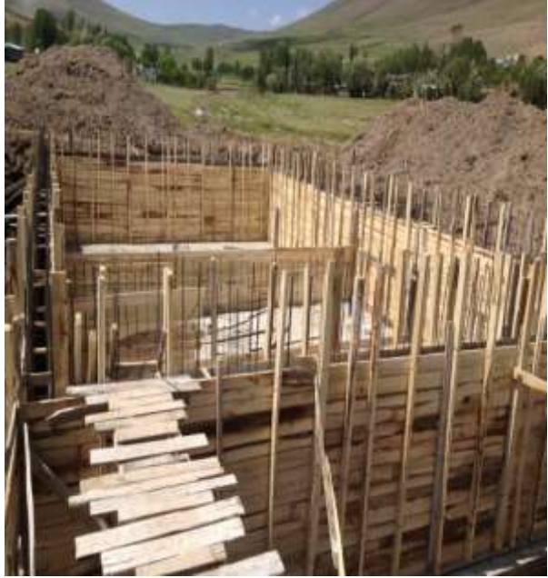
Abbasgöl Köyü Kanalizasyon şebekesi foseptik kuyusu inşaatı
