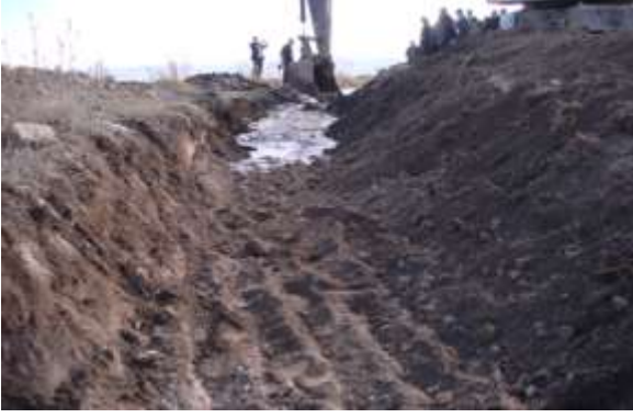
Sulama Kanalı Temizliği
