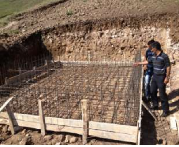
Elmagöl köyü, Bezirhane, Çiko ve Köprükoy Mezraları İçme Suyu Gömme Depo inşaatı
