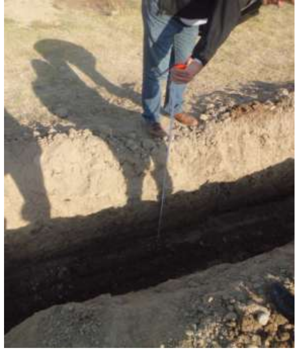
Sarıçoban köyü ek içme suyu hattı inşaatı
